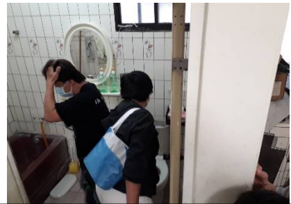
水電課程:馬桶修繕，簡易的故障排除
